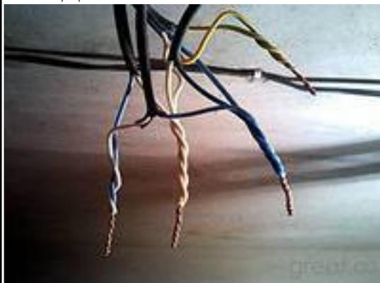
Еще раньше, скрутка являлась самым распространенным способом соединения проводов при электромонтаже проводки, благодаря простоте исполнения, из инструмента достаточно было
